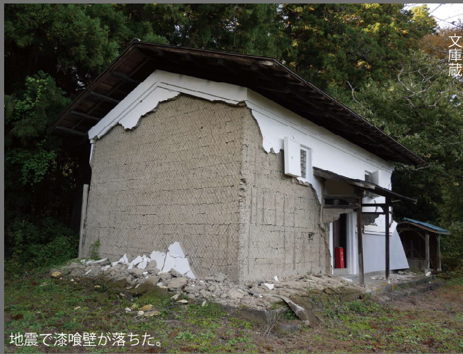
屋根の厚みが経年で薄くなった。地震で壁に亀裂が入った。
