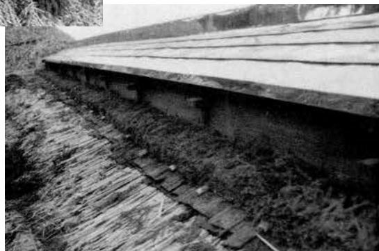
<昭和57年修理時の箱棟組立状況>
