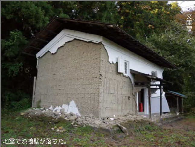
屋根の厚みが経年で薄くなった。地震で壁に亀裂が入った。
