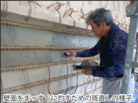
多種多様な鏝を駆使して壁を塗り上げる。
