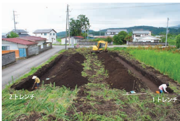
写真5 トレンチ掘削状況（北から）
