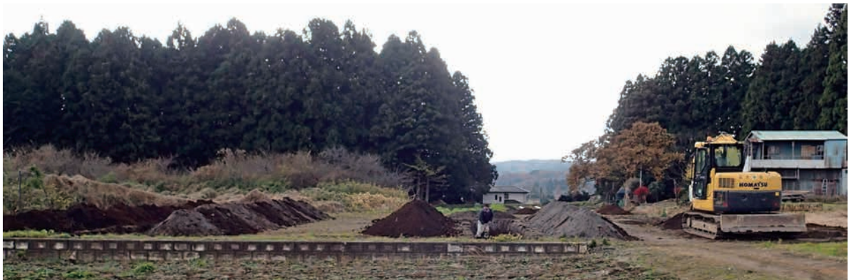
写真25 トレンチ掘削状況（北東から）
