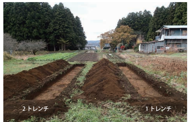
写真 15 トレンチ掘削状況（北東から）
