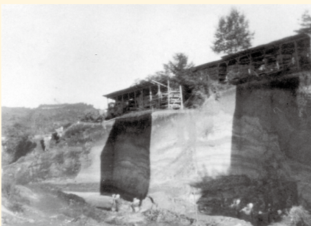
円田珪藻土の採掘場と乾燥小屋
