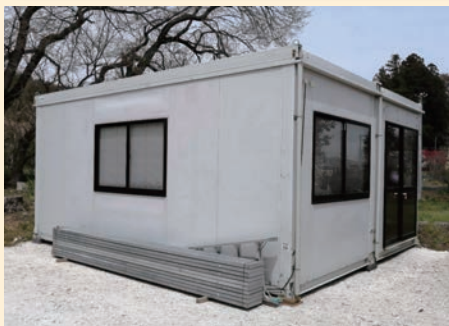
現場事務所のプレハブが搬入されました。機材を搬入しいよいよ発掘調査開始です。
