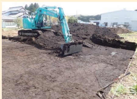
法面用の平らなバケットを装着した重機に指示を出しながら表土を掘り下げていきます。
