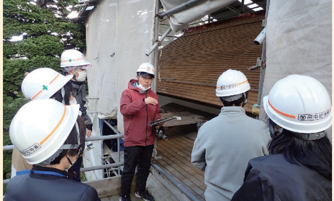
保存修理工事見学会 前蔵のこけら葺き屋根の葺き替え現場。腐りにくい栗材の手割り板を幾重にも重ねて葺かれています。
