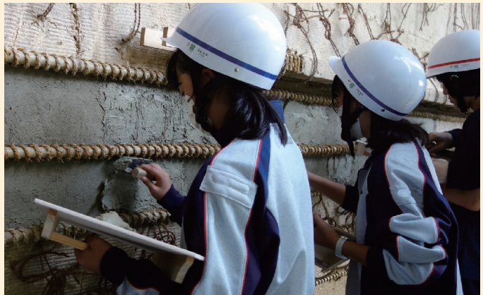
伝統工法による土壁塗り作業の体験 宮中学校の生徒が「蔵王を知る研修」で文庫蔵の土壁の中塗り作業を体験しました。
