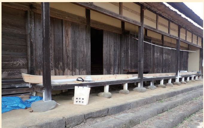
前葺の『樋棟』。長さ12mほどもあり、3つの材を組み継いで作られている。これを銅板で包んで棟に据える。
