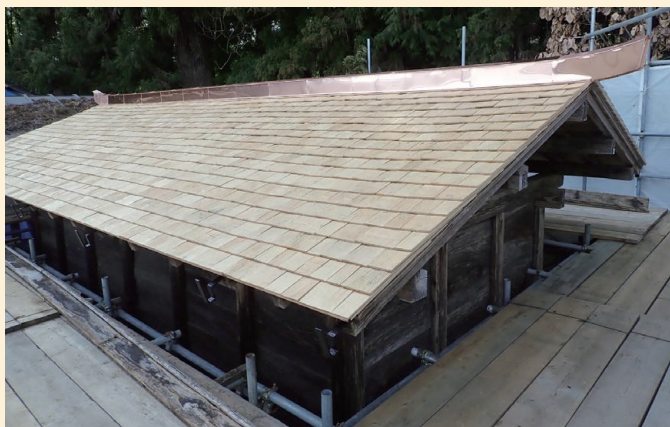
葺き終えた板葺。整然と並んだ真新しい『こけら板』が美しい。棟（屋根の最上部）には銅板で包んだ『樋棟』を据える。
