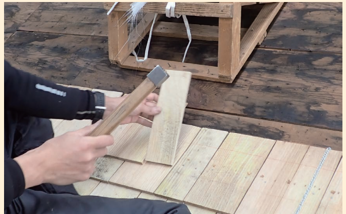
職人が使う金づちは、こけら葺き専用の特別なもの。柄が短く、釘を叩く頭の部分はサイコロのような形をしている。
