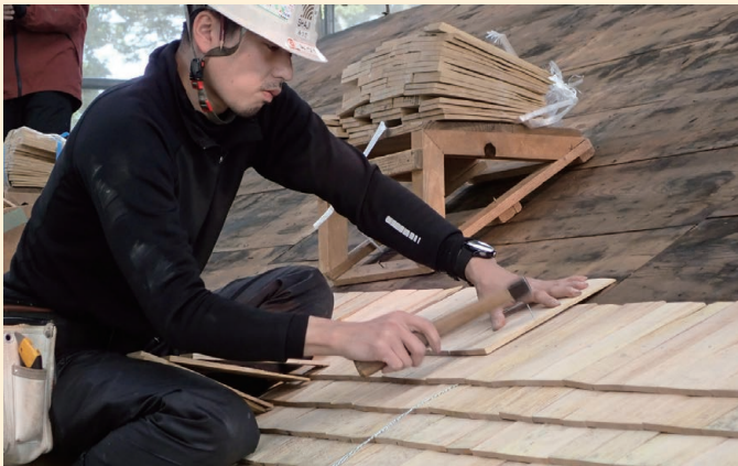
こけら葺き作業。栗材を手割りした『こけら板』を、板の端を一直線に揃えながら、一枚ずつ釘止めしていく。
