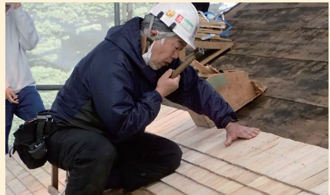
数十本の釘を口に含み、舌と唇を使って向きを揃え、一本ずつ出す。これが一番効率が良い。「慣れないうちは口の中が傷だらけになるんだ。」とのこと。
